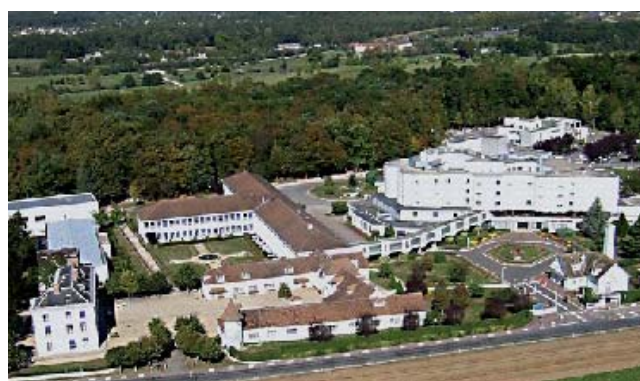
Figure 1. Vue d'ensemble du centre médical de Forcilles.
