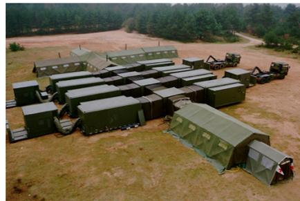
Figure 7. Ensemble (GMC) de containers médico-chirurgicaux reliés par des sas étanches avec modules de servitude.
